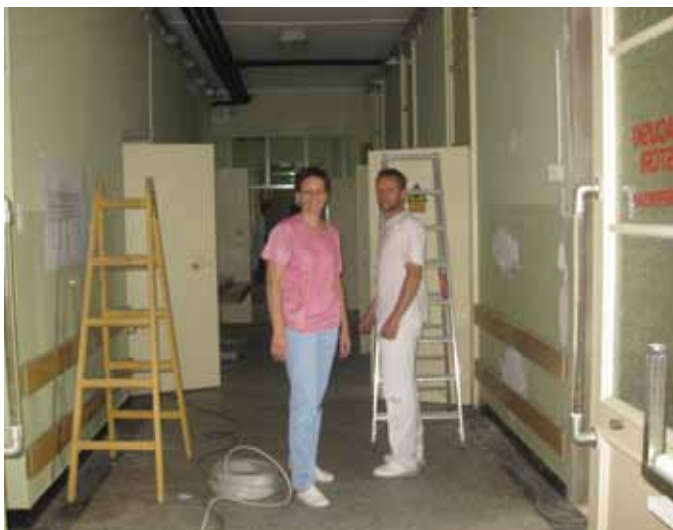
Gradbišče na »novi« lokaciji
